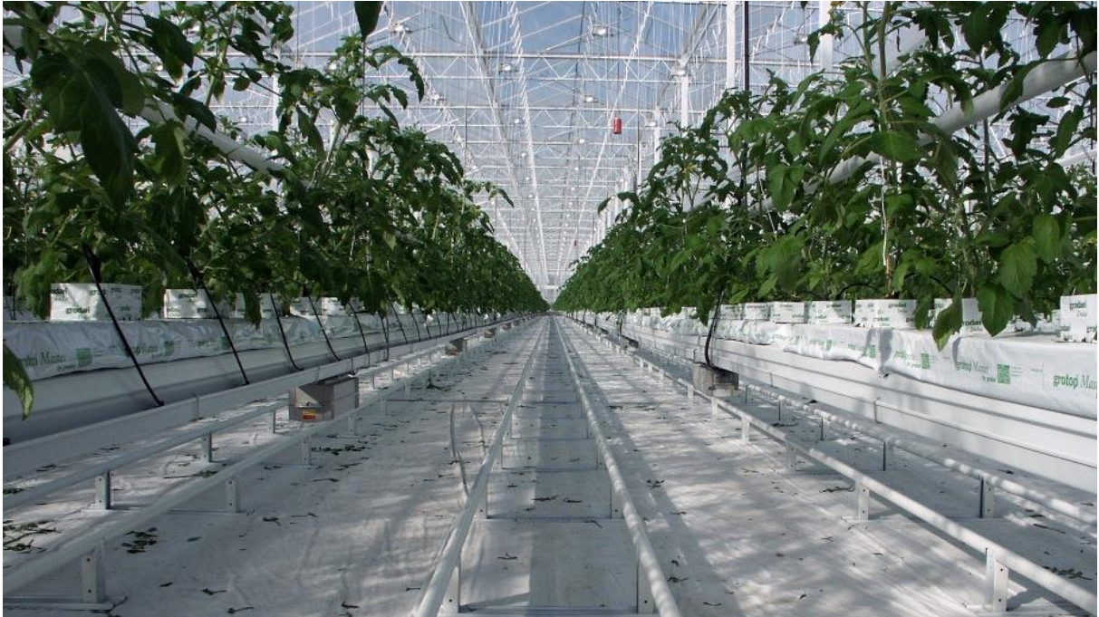
Isıtma sistemi ve askılı yerleştirme olukları
